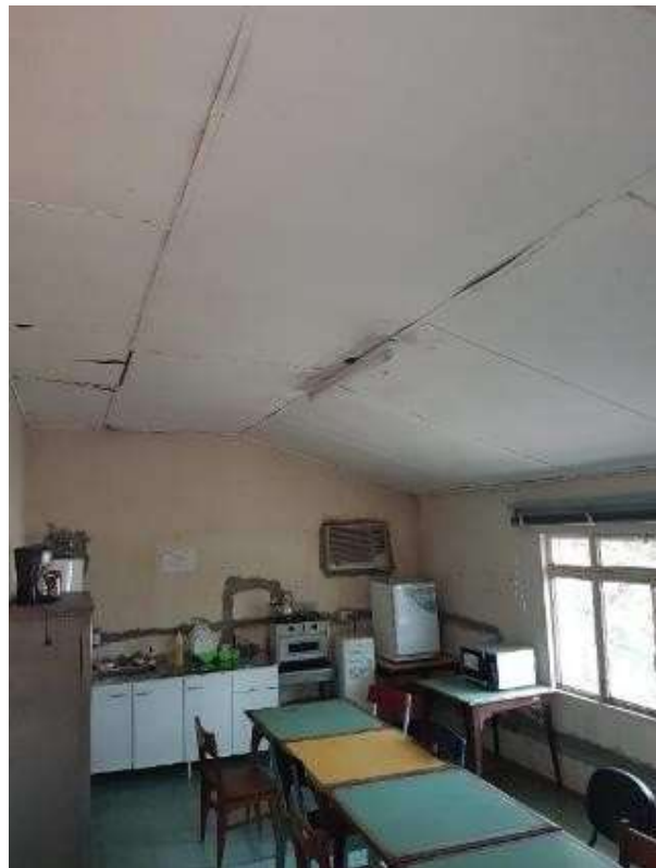
Office de PA a cambiar piso, cielorraso y pintura general. Local N° 12
