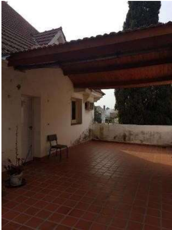
Conector a cerrar con mampostería. Local N° 11
