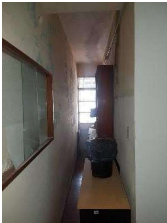
Tabique a demoler de actual pasillo de PB
