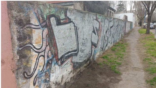
ESTADO MURO A DEMOLER
