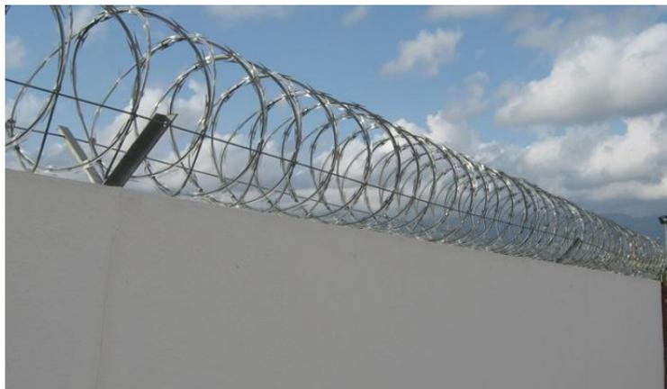
Instalación de alambrado tipo concertina, sobre sectores de muros existentes. Colocación de soportes metálicos tipo "Y"
