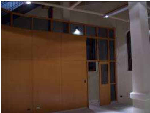
Tabique de aulas (1ero al 3er piso).
