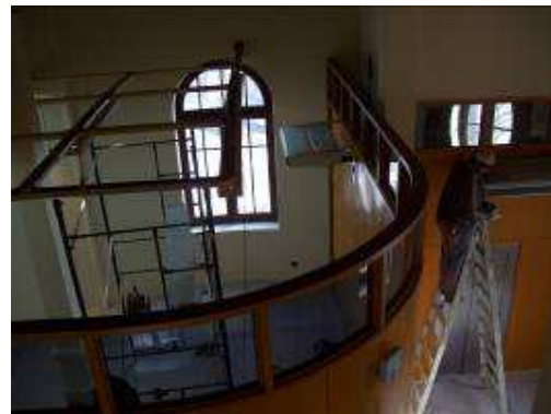
Completamiento de tabiques
