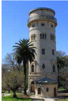
Vista Torre Tanque
