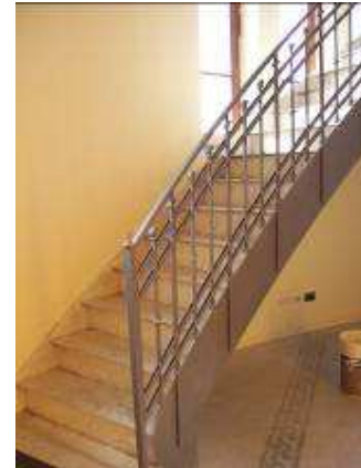
Escalera metálica a revestir.
